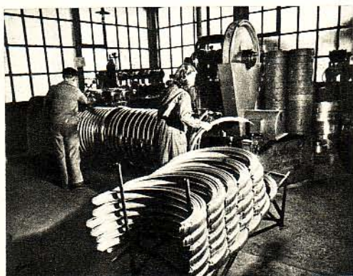
ROULAGE ET CISAILLAGE DES GARDE-BOUE.
